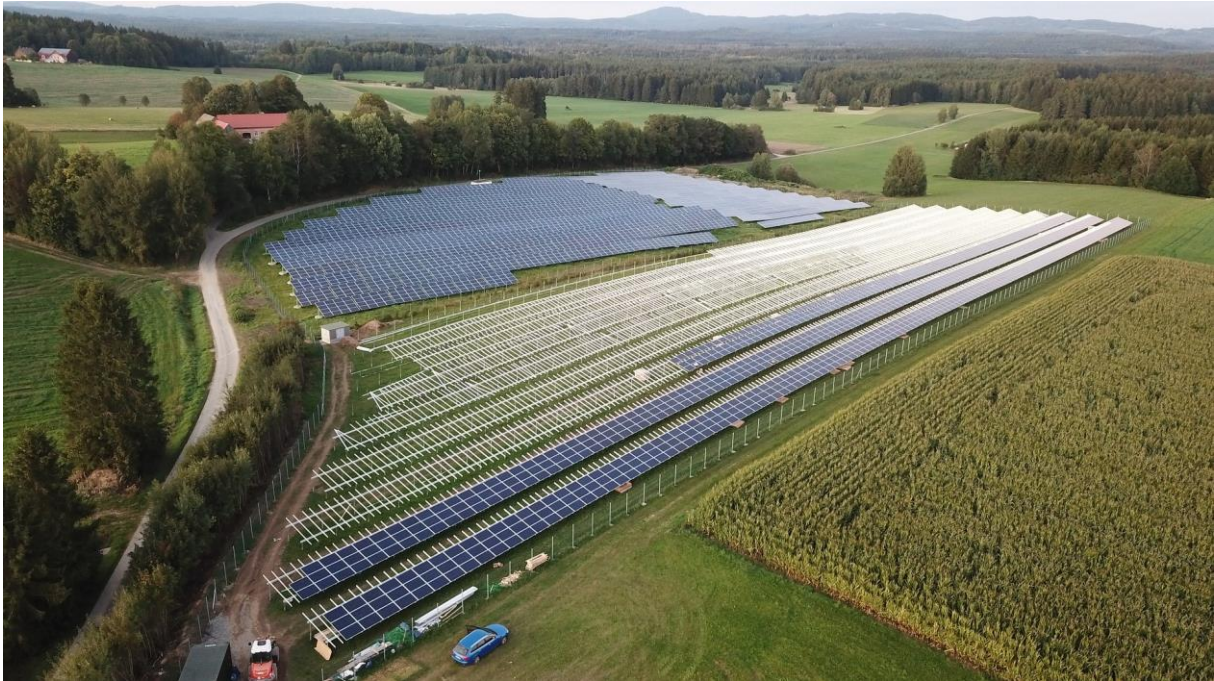
Bakkemontert solcellepark under bygging. Foto: Pixabay.
