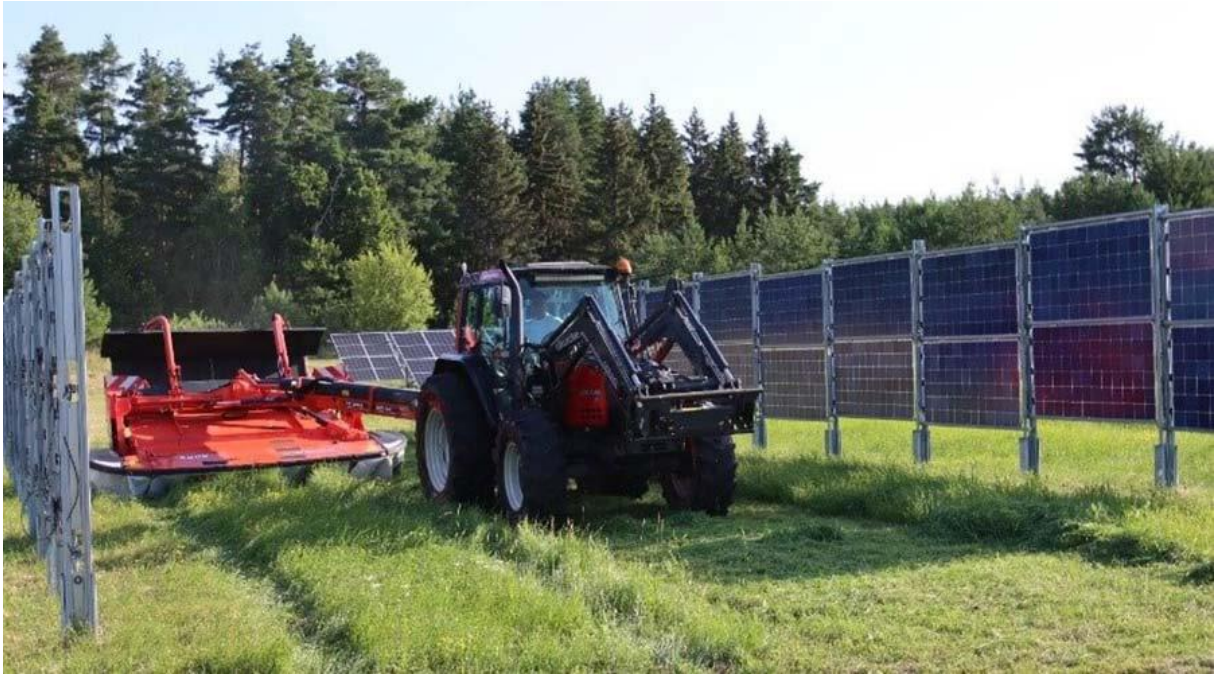
Pilotanlegget på Kärrbo Prestegård utenfor Västerås. Foto: Next2Sun.
