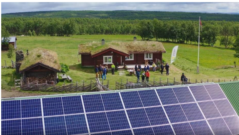
Dronebilde av setra til Erling og Hanne. Foto: EnergiPluss.
