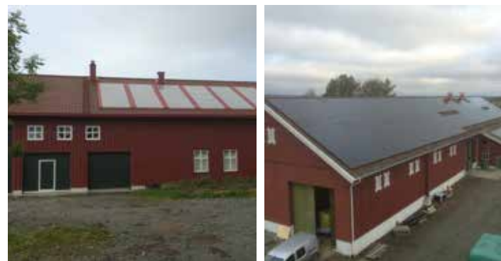
Solfangere (til venstre) og solceller (til høyre) på Grøndalen Gårdsmeieri på Auli (Akershus)
